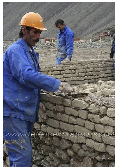
Na fotografii je kamenná zeď postavena na kanálu k nové hydroelektrárně na Anabe, Afghánistán
